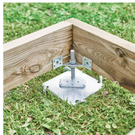
6. Ajuster et mettre à niveau le cadre
