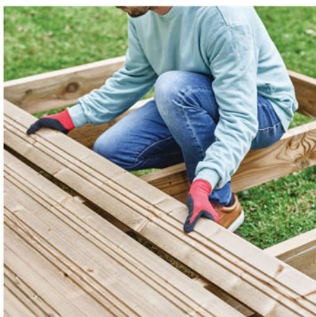
8. Installer les lames pour finir le plancher
