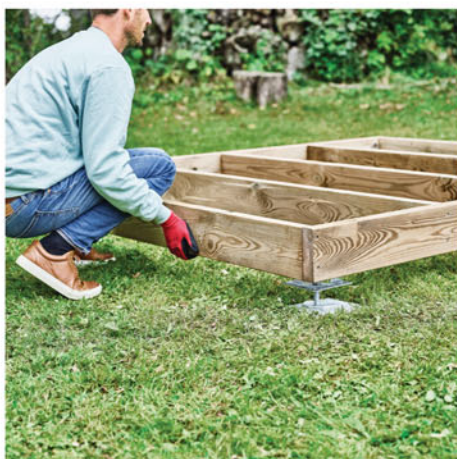
5. Positionner le cadre sur les équerres
