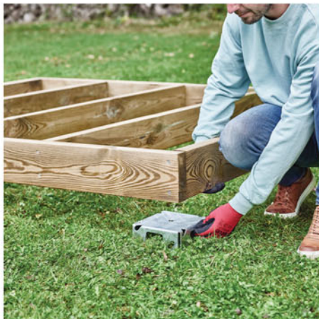
2. Positionner les embases sous le cadre
