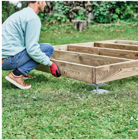
5. Positionner le cadre sur les équerres.
