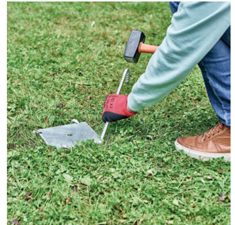
3. Ancrer les embases en plantant les piquets d'ancrage.
