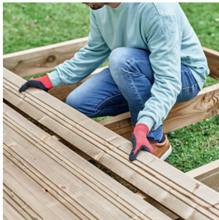
8. Installer les lames pour finir le plancher.
