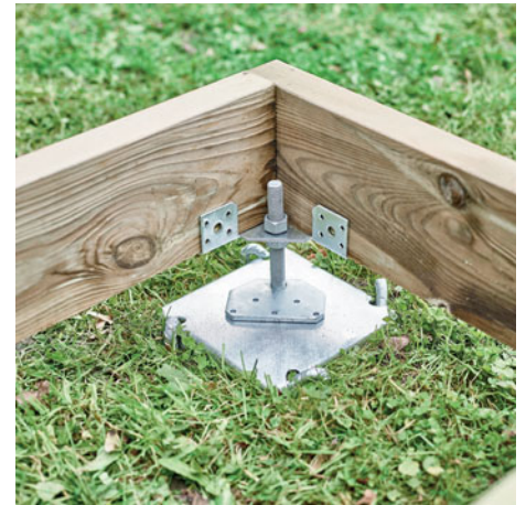
6. Ajuster et mettre à niveau le cadre.
