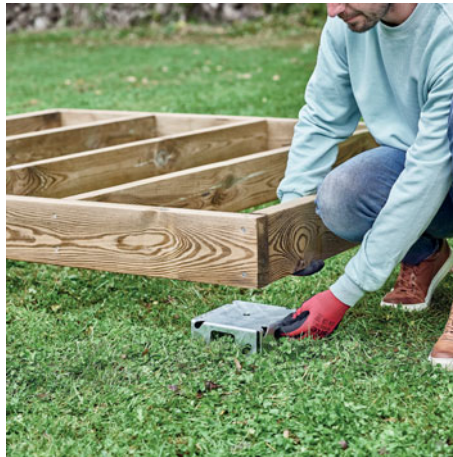
2. Positionner les embases sous le cadre.
