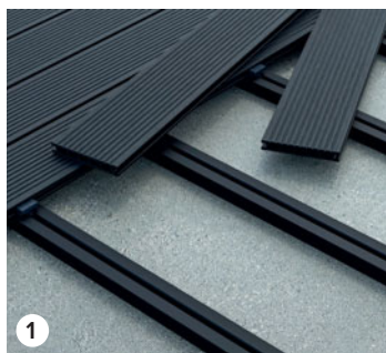
En composite : pose sur sol béton
