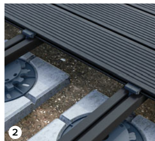
2 En aluminium sur plots et sol béton
